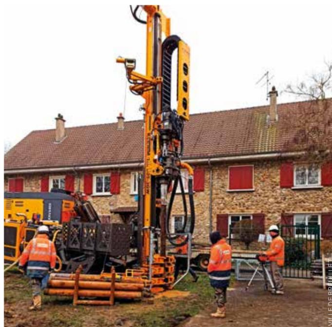
Les deux installations géothermiques de Breuillet comptent respectivement neuf et douze sondes à 200 mètres de profondeur.
